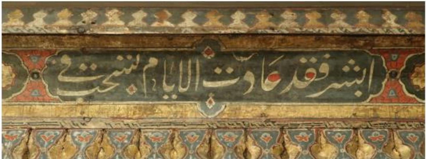
Abb. 4: Detail des Gesimses von Wand E nach der Konservierung/Restaurierung der Schriftkartusche einschließlich Retusche
