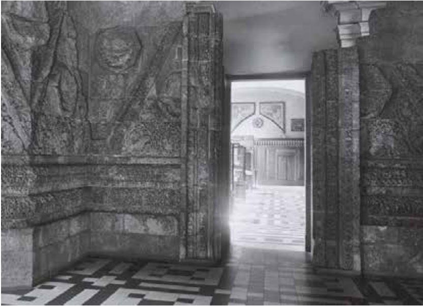
2 Blick durch die Mschatta-Fassade: Die Islamische Abteilung im Kaiser Friedrich-Museum ab 1904
